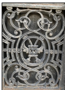
Figura 16: rejas de la rotonda del Cementerio Central. El proyecto de la rotonda culminó en 1863. Fotografía propia.
